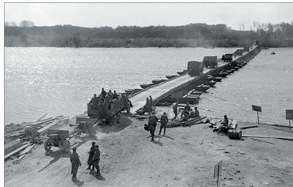
April 1945: Zusätzlich wurde nordostwärts von Hainburg eine Pontonbrücke über die Donau errichtet. Hier wurden die Schützenkorps der 46. Armee in kürzester Zeit mit ihren Verbänden über die Donau gesetzt. (Foto: RGKFD)
